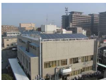
上下水道局別館
