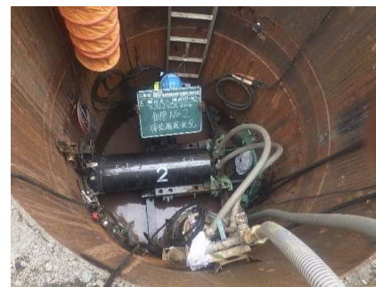
下水道管路の布設工事
