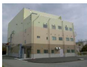
下水汚泥固形燃料化施設
