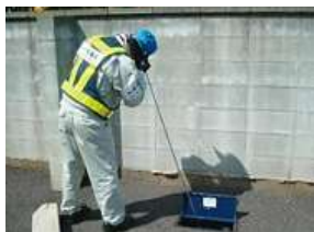
漏水調査の様子
