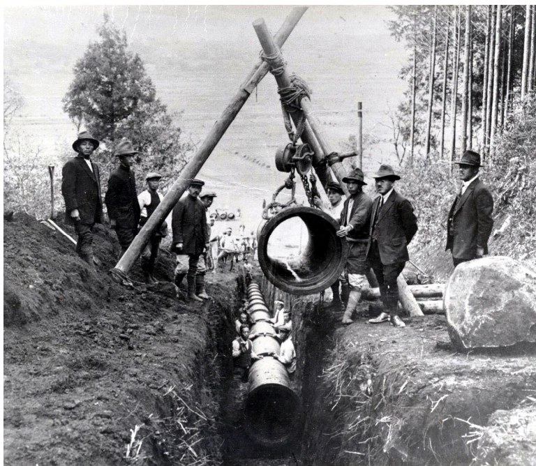
立田山送水管布設工事（大正期）
