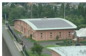
(中)八景水谷送水場
