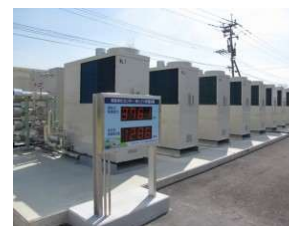
東部浄化センター消化ガス発電設備(マイクロエンジン)
