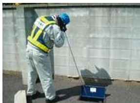
漏水調査の様子
