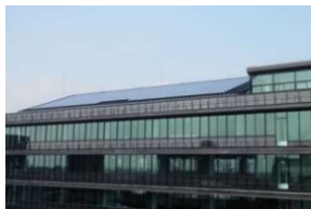
【水道施設の太陽光発電設備】 (左)上下水道局本館
