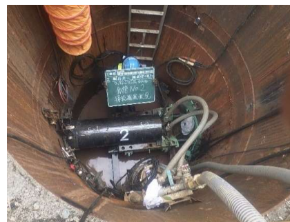
下水道管路の布設工事
