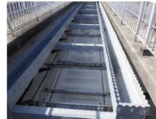
南部浄化センター最終沈殿池設備改築
