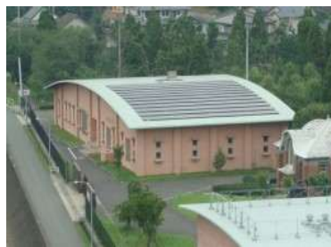
八景水谷送水場
