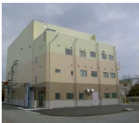
固形燃料化施設
