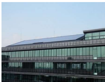
上下水道局本館
