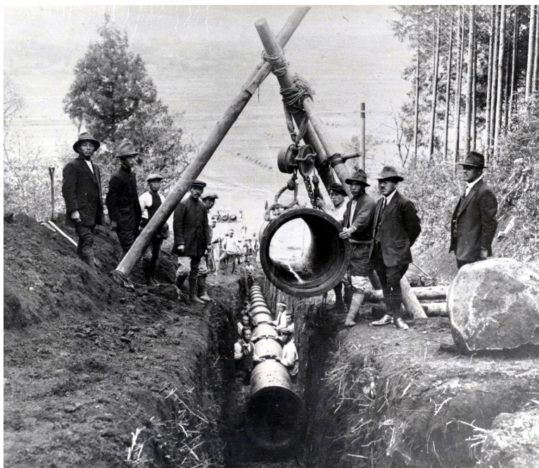
立田山送水管布設工事（大正期）
