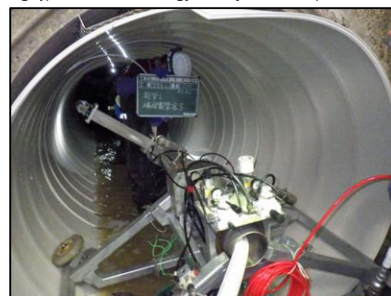
▲計画的な改築・更新（管路の更生工法）
