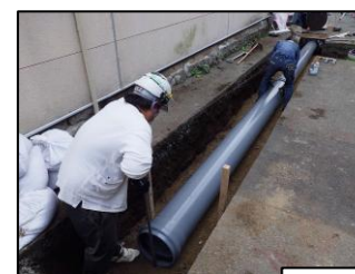
▲管路の布設替
