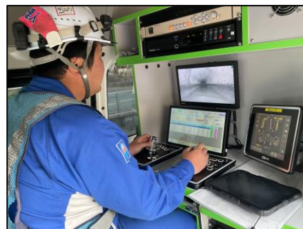
▲下水道管路内部の調査（テレビカメラ）
