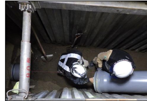
▲下水道管路の改築更新（布設替）
