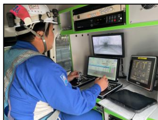
▲カメラ調査（小口径管）
