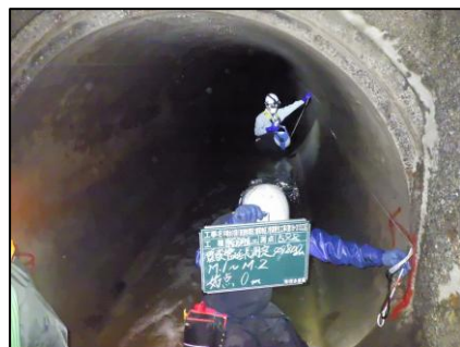
▲下水道管路内部の調査（目視）
