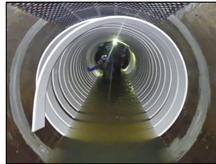
▲下水道管路の改築更新（内面更生）
