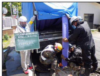
▲計画的な改築・更新（管路の更生工法）
