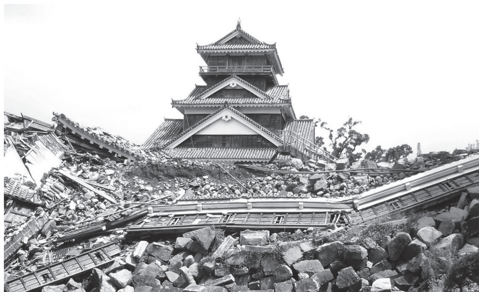
写真2-2-1 熊本城類当御門周辺の石垣の崩壊
