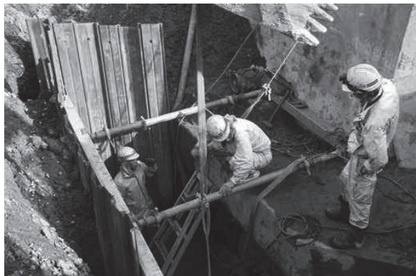
写真2-2-8 被災した上水道管路の整備
