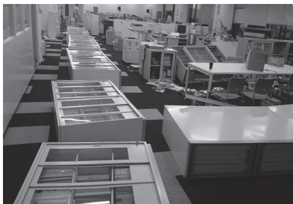
写真2-2-5 上下水道局庁舎執務室の書庫・ロッカーなどの倒壊
