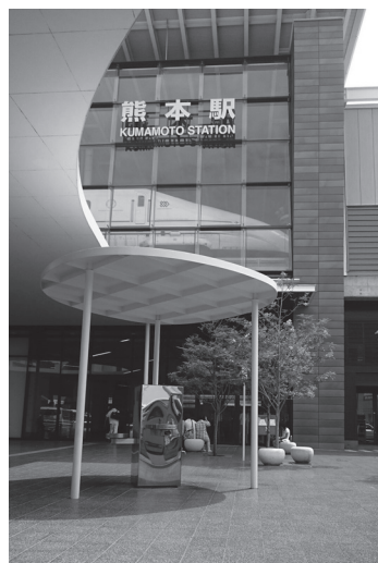
写真2-3-7 熊本駅新幹線口 ウォーターステーション
