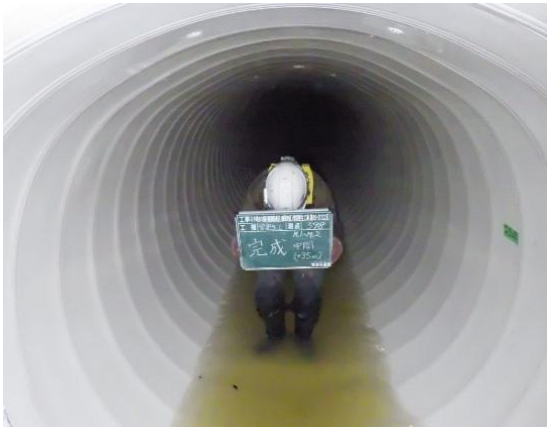
下水道管路の改築更新工事
