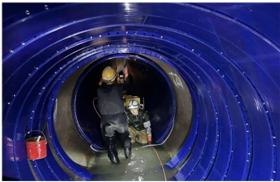
中部合流6号幹線の耐震化工事
