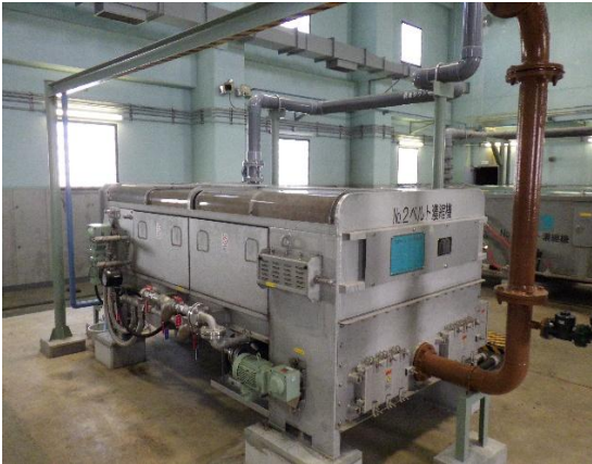
更新した下水道施設(機械濃縮設備)
