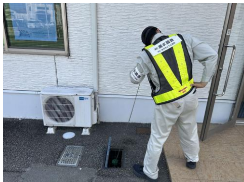
音聴棒による漏水調査
