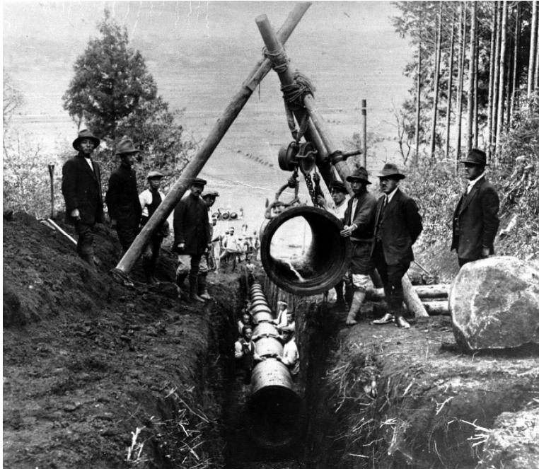
立田山送水管布設工事（大正期）
