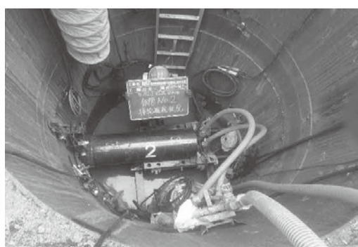
下水道管路の布設工事
