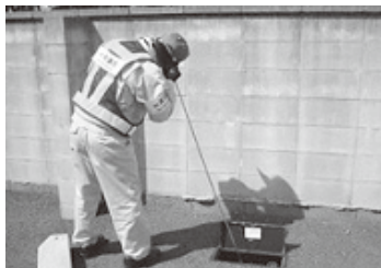
漏水調査の様子
