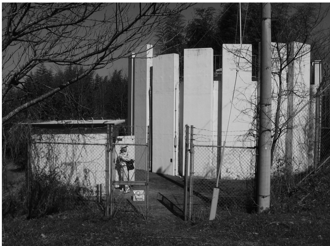
工業用水道配水池
