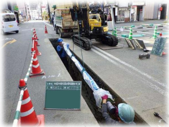
▲水道管布設工事状況(路線A)
