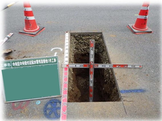
▲試掘工事状況(路線C)
