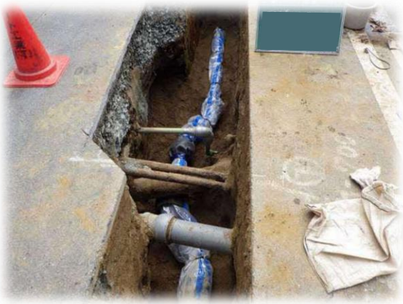
▲水道管布設後状況(路線A)
