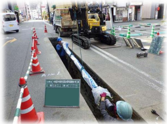
▲水道管布設工事状況(路線A)
