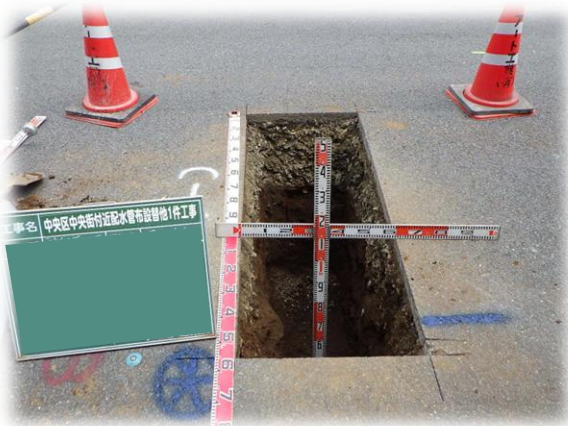
▲試掘工事状況(路線C)
