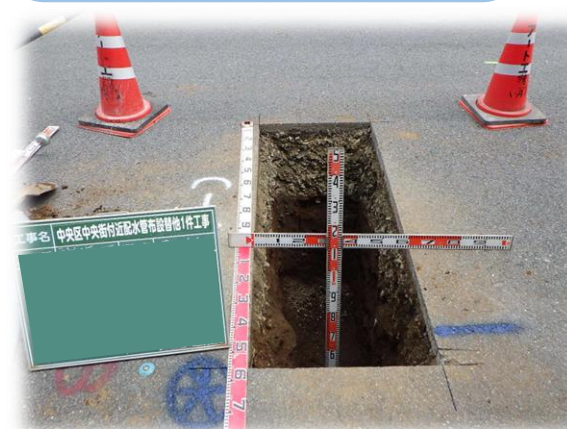
▲試掘工事状況(路線E)
