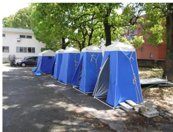
マンホールトイレの設置状況
