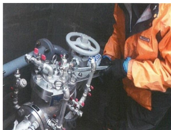
減圧弁の分解整備
