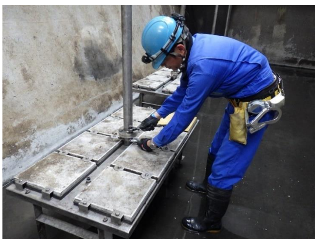
設備の点検調査
