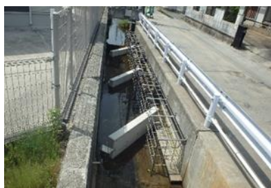
分水施設(井芹川第9排水区)
