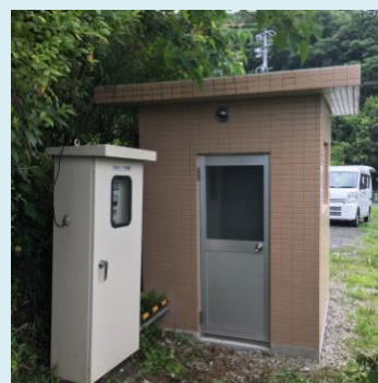
更新後の建屋(井戸ポンプ)
