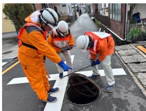
能登半島地震における下水道施設の被害調査
