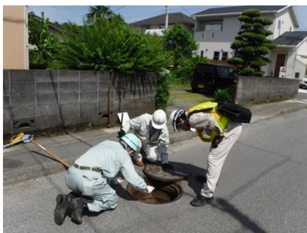
下水道管路の点検調査
