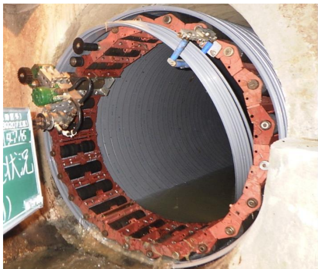
下水道管路の改築更新工事
