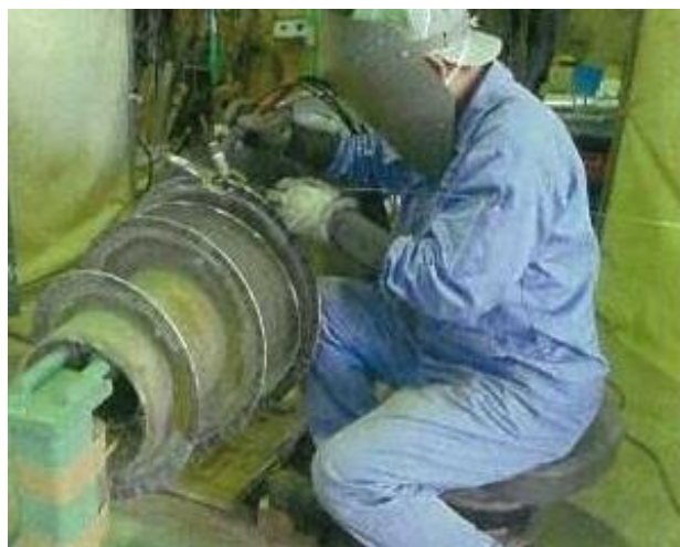
分解整備による修繕
