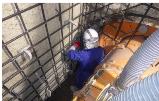
マンホールの耐震化工事
