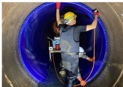
下水道管渠の耐震化工事
