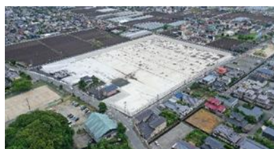
調整池(坪井川第3排水区)
