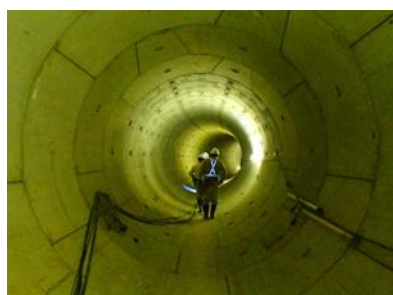
雨水貯留管(加勢川第6排水区)
