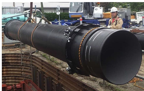
基幹管路の耐震化工事(更新)
