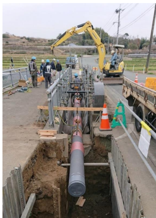
水道管路の更新工事
