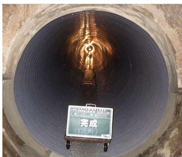
下水道管路の改築更新工事
