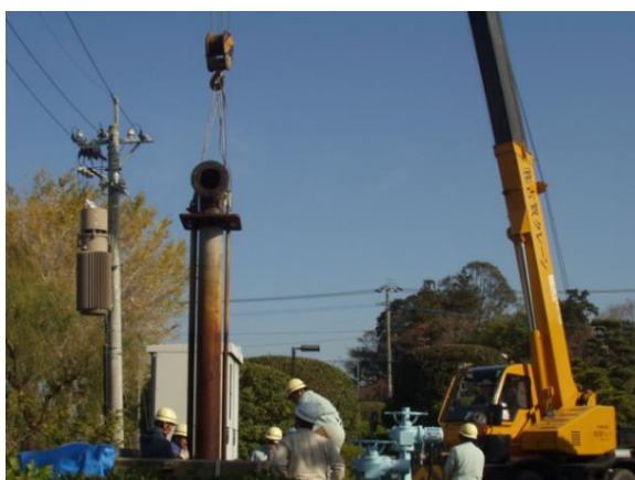
井戸の更生工事
