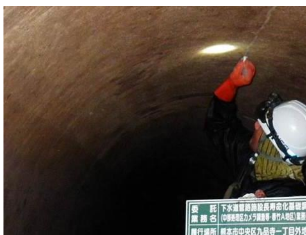
下水道管路内部の点検調査
