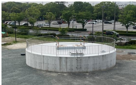
耐震化(更新)した水道の基幹施設
