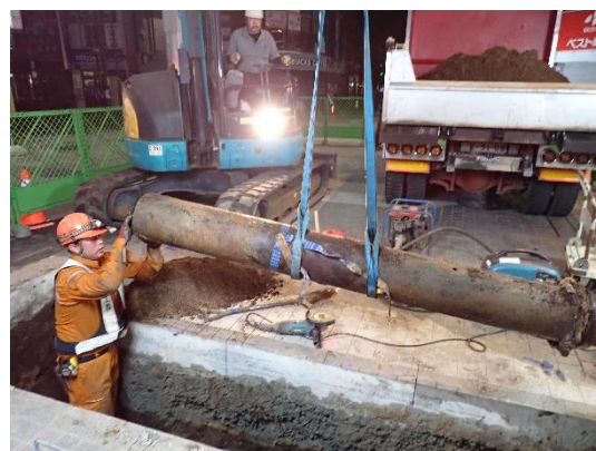
写真 3-8-4-1 更新工事により取り除かれた老朽管
