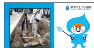
水道工事を 行っています
