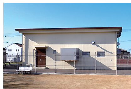
富合東部水源地 築造平成29年8月
