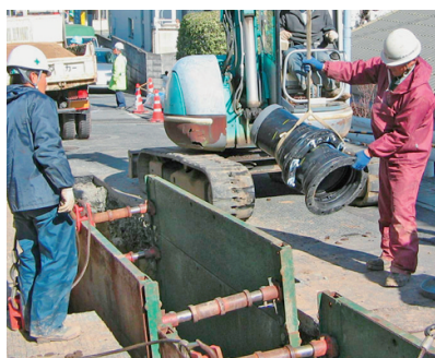
水道管の耐震化 既設基幹管路などを 耐震管に布設替しています
