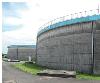
配水池(災害対策用貯水施設) 地震発生時、緊急遮断弁によって 配水池の水を確保します
