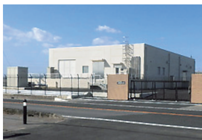
南部送水場 築造平成29年8月
