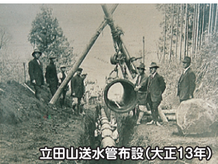
立田山送水管布設(大正13年)
