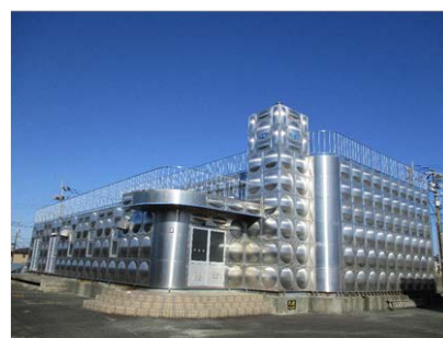
一木配水場（植木）
