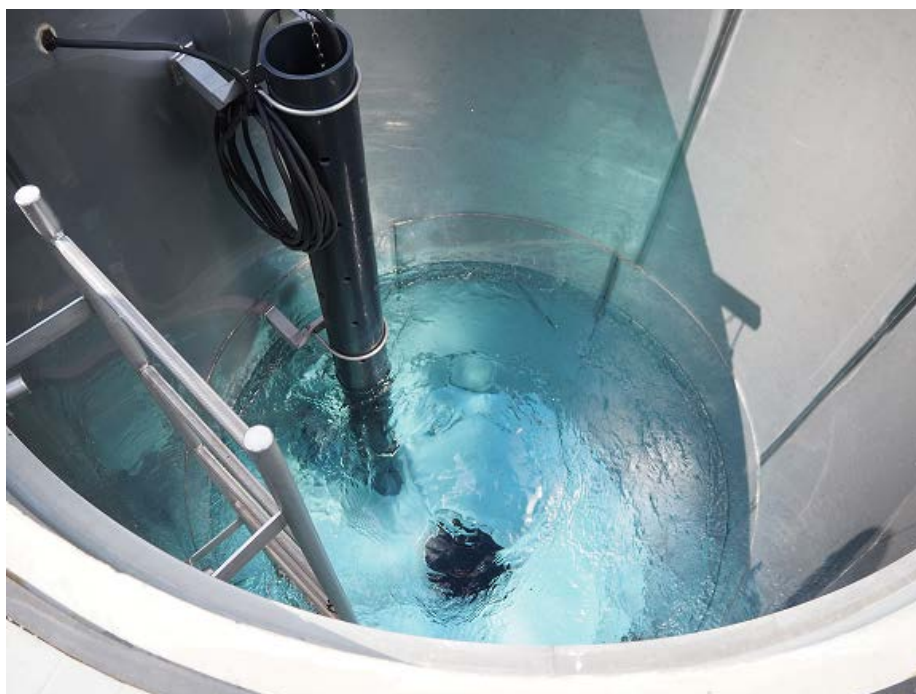
健軍水源地取水井内部
