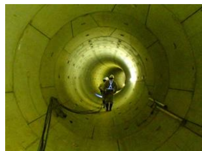
写真 4-2-1 雨水貯留管(加勢川第6排水区)
