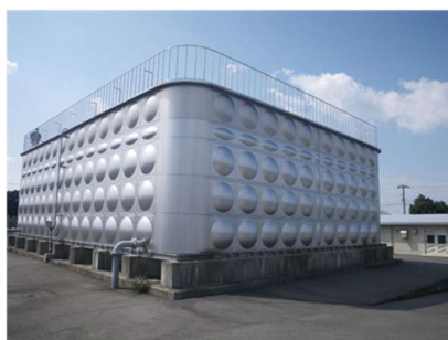
舞原配水場（城南）
