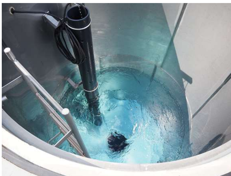
健軍水源地取水井内部
