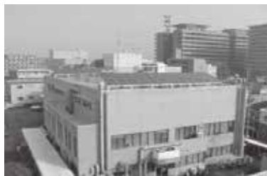
上下水道局別館
