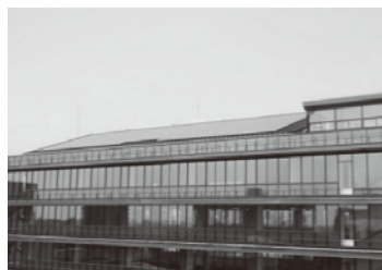
上下水道局本館
