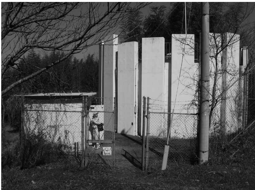
工業用水道配水池
