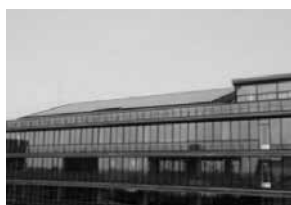
水道施設の太陽光発電設備
