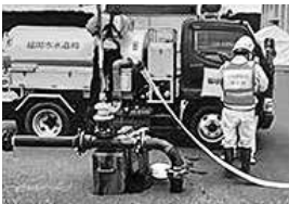
上水道防災訓練
