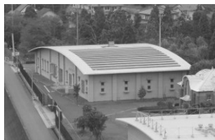
(左) 上下水道局本館 (右) 八景水谷送水場
