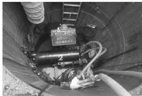
下水道管路の布設工事
