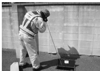
漏水調査の様子
