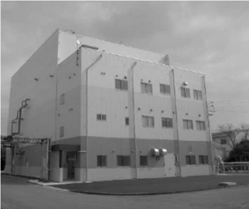
固形燃料化施設
