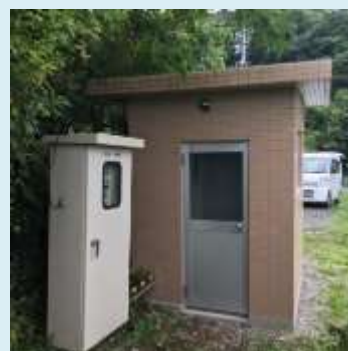
更新後の建屋(井戸ポンプ)
