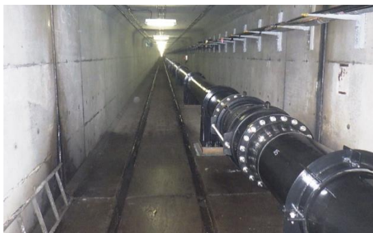
耐震化した水道の基幹管路
