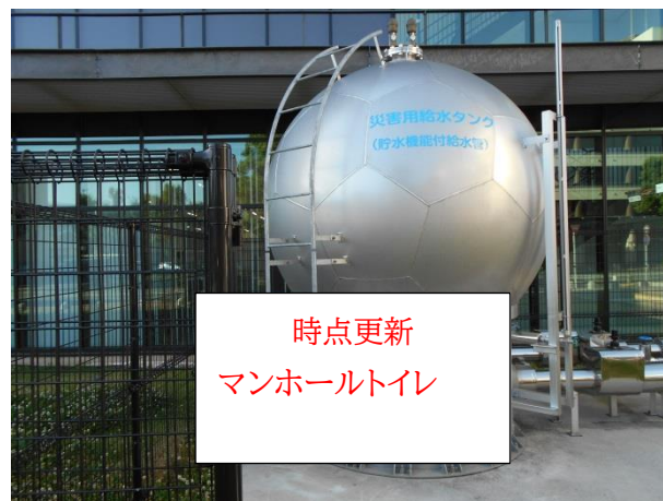
上下水道局内に設置した貯水機能付給水管
