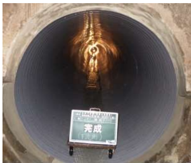
下水道管路の改築更新工事
