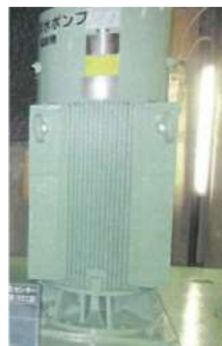
更新した汚水ポンプ (中部浄化センター)
