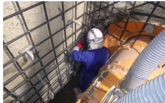
マンホールの耐震化工事
