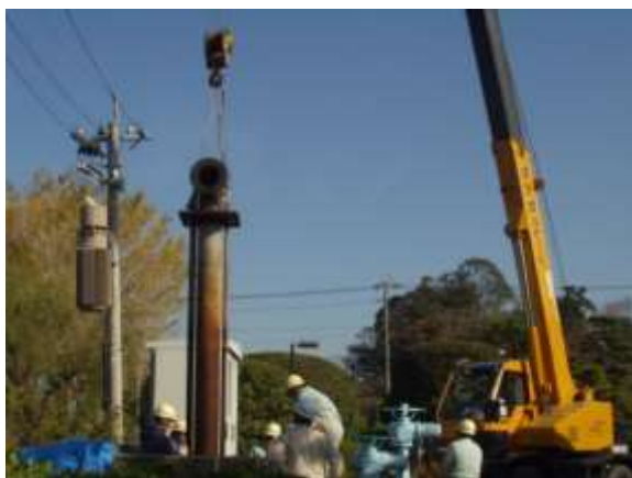
井戸の更生工事
