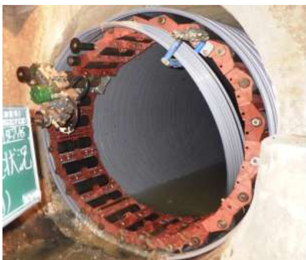
下水道管路の改築更新工事
