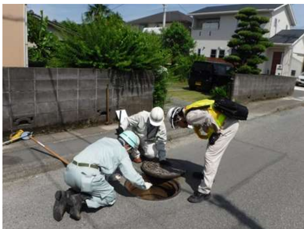
下水道管路の点検調査
