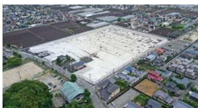
調整池(坪井川第3排水区)
