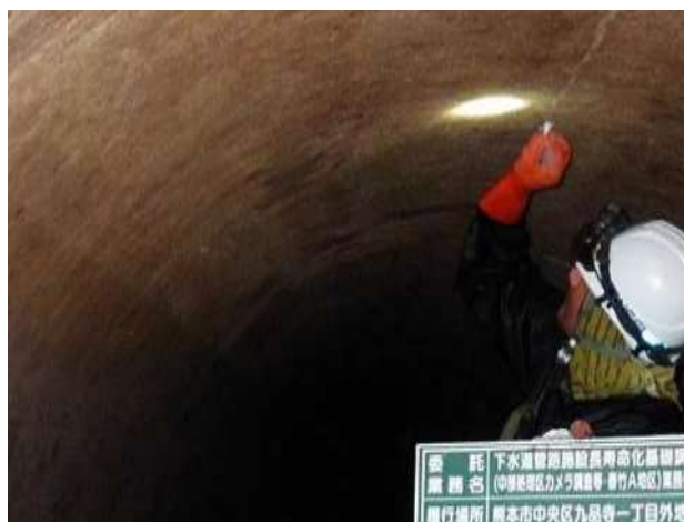
下水道管路内部の点検調査
