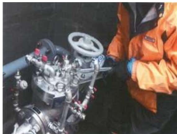
減圧弁の分解整備
