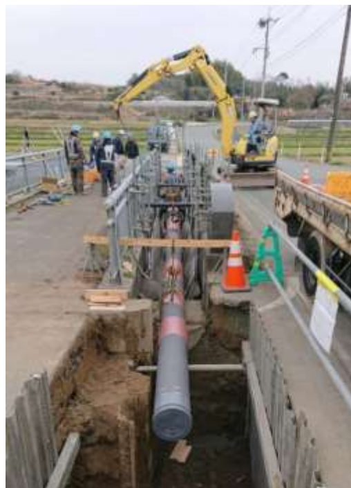
水道管路の更新工事
