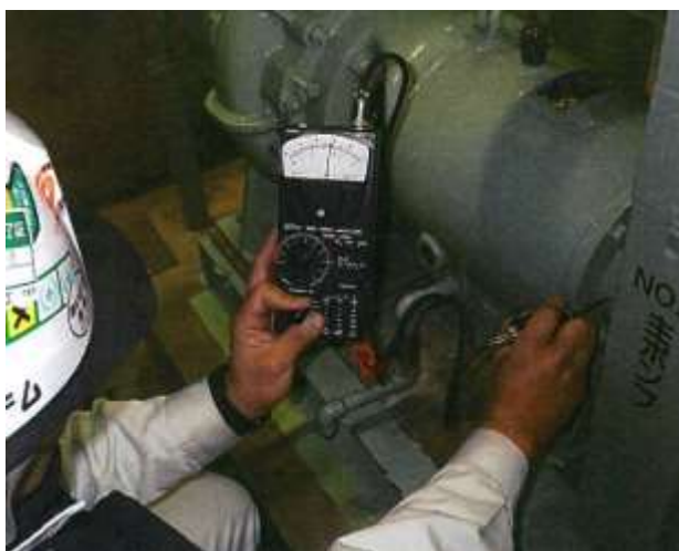
ポンプ等設備の点検調査
