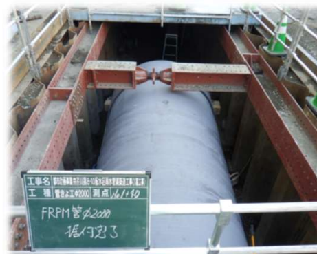
井芹川第8・10排水区 雨水管渠整備
