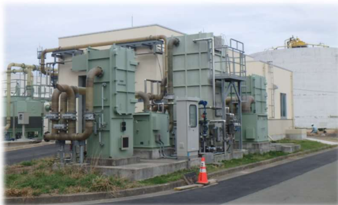
東部浄化センター し尿受入施設
