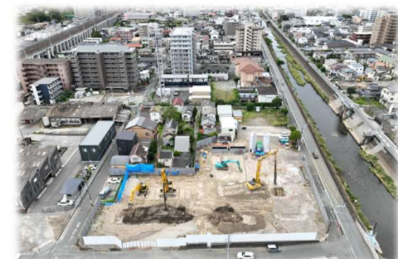
井芹川第8・10排水区 雨水ポンプ場建設
