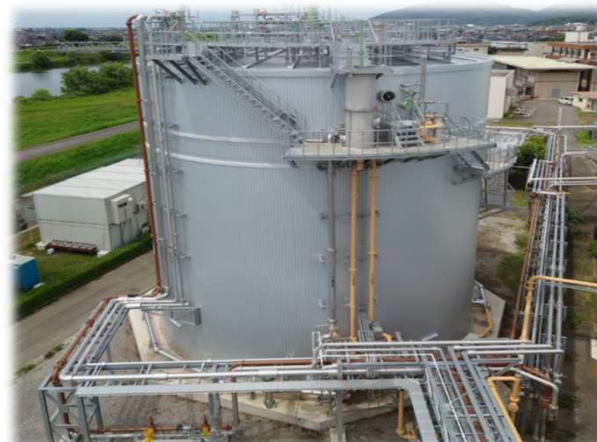
中部浄化センターB系消化槽改築工事
