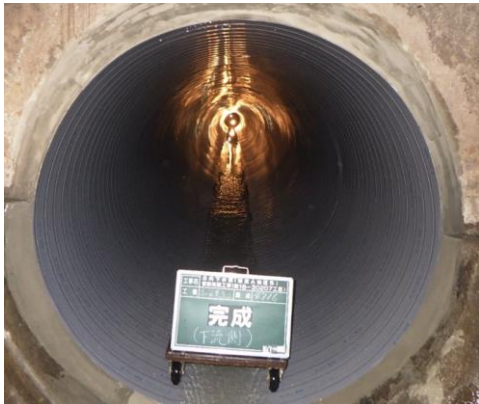
下水道管路の改築更新工事
