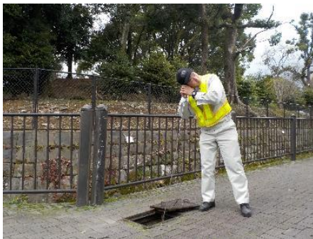
音聴棒による漏水調査
