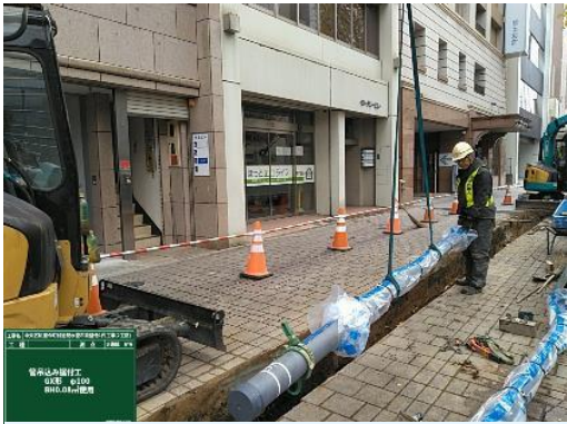
中心市街地の配水管更新
