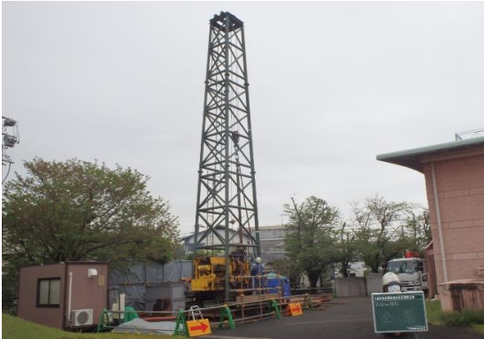
八景水谷取水2号井の更新工事
