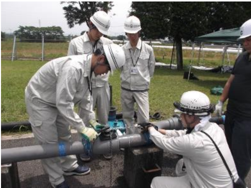
内部講師による配管実技研修
