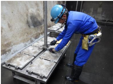
下水道施設の点検調査
