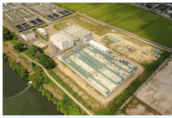
高度処理施設の整備(R6供用開始予定)
