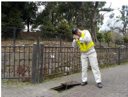
音聴棒による漏水調査
