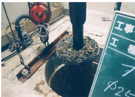
井戸の更生工事
