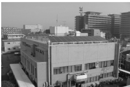
上下水道局別館
