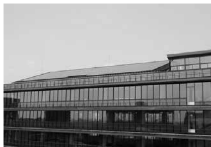
上下水道局本館
