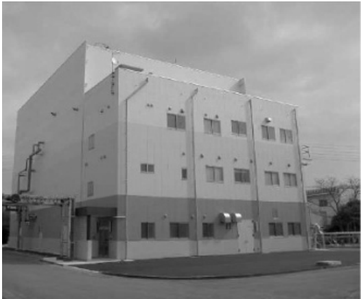
固形燃料化施設
