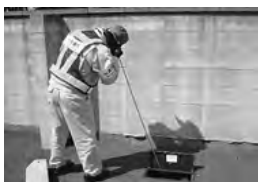
漏水調査の様子
