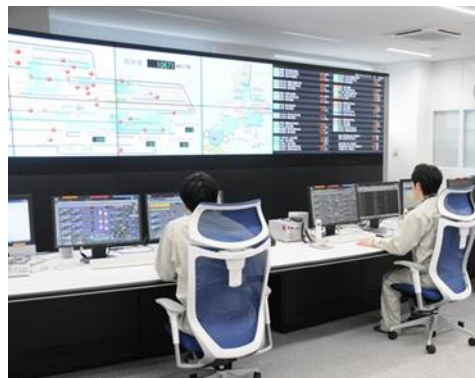
写真 2-1-1 水運用センター
