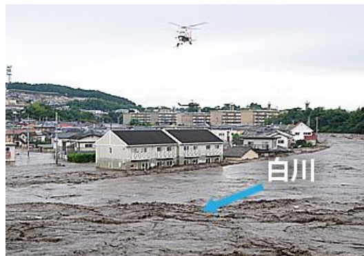
写真 3-5-2-2 平成 24 年九州北部豪雨の被害状況 出典：国土交通省 熊本河川国道事務所ホームページ 「平成 24 年 7 月洪水(九州北部豪雨)」
