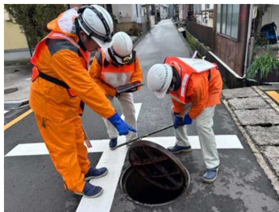
写真 3-4-3-2 下水道施設の被害調査(能登半島地震)
