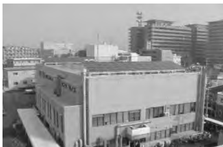
上下水道局別館
