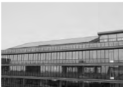
上下水道局本館
