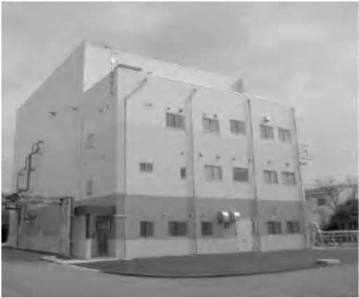
固形燃料化施設
