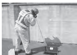
漏水調査の様子
