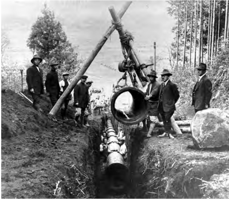
八景水谷送水管布設工事（大正期）
