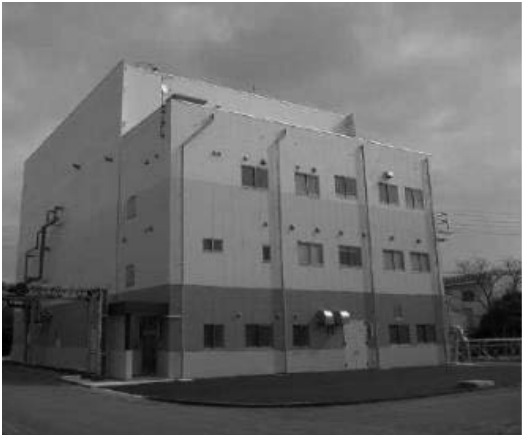
固形燃料化施設
