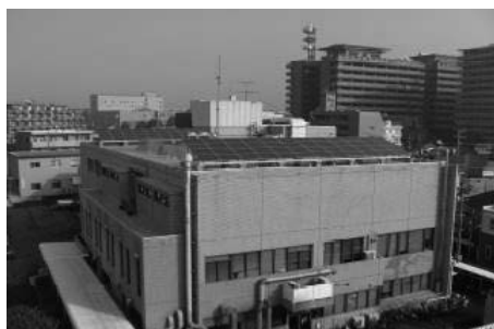
上下水道局別館
