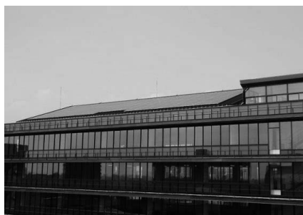
上下水道局本館
