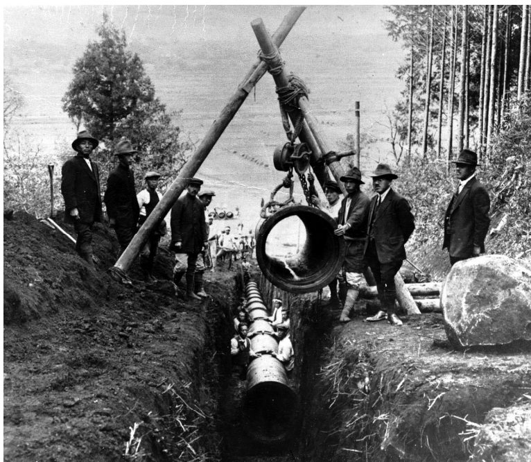
八景水谷送水管布設工事（大正期）
