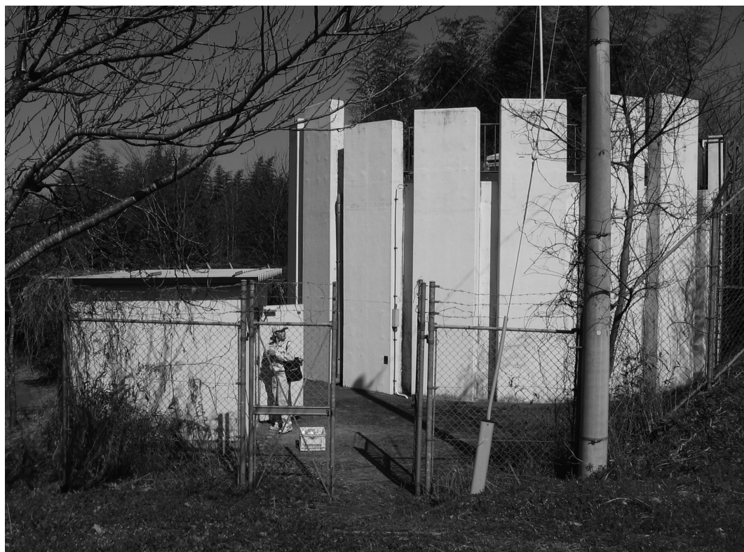
工業用水道配水池
