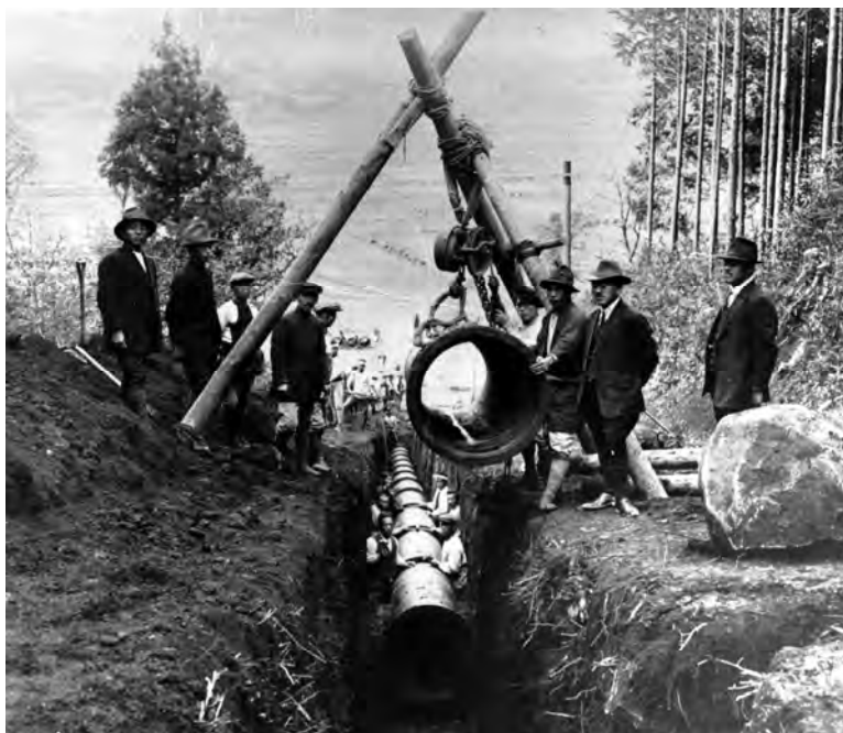
八景水谷送水管布設工事（大正期）
