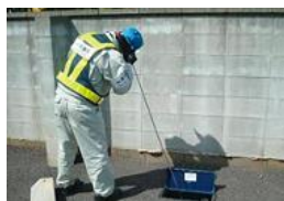
漏水調査の様子
