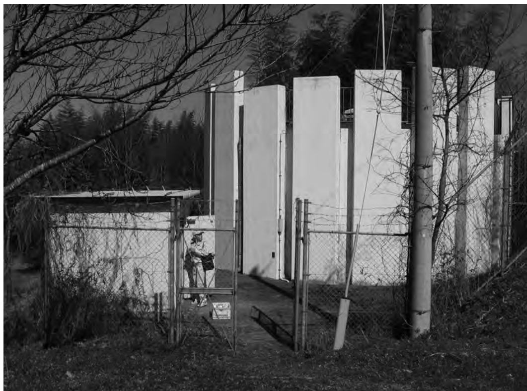
工業用水道配水池
