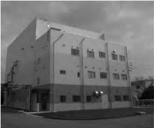
固形燃料化施設
