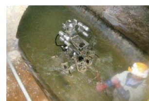
テレビカメラ調査等により、管きよの状態を調べています
